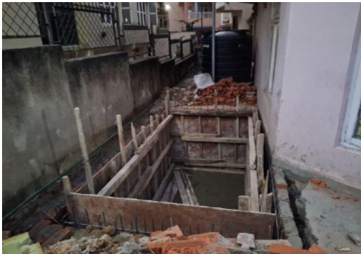
Im Pinkhaus wird ein Wassertank im Boden des Vorgartens eingebaut.
